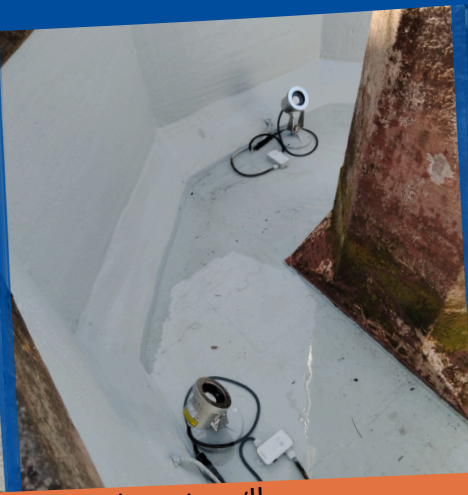
Fontaine du centre village : après des travaux d'étanchéité et de peinture, installation d'un nouvel éclairage
