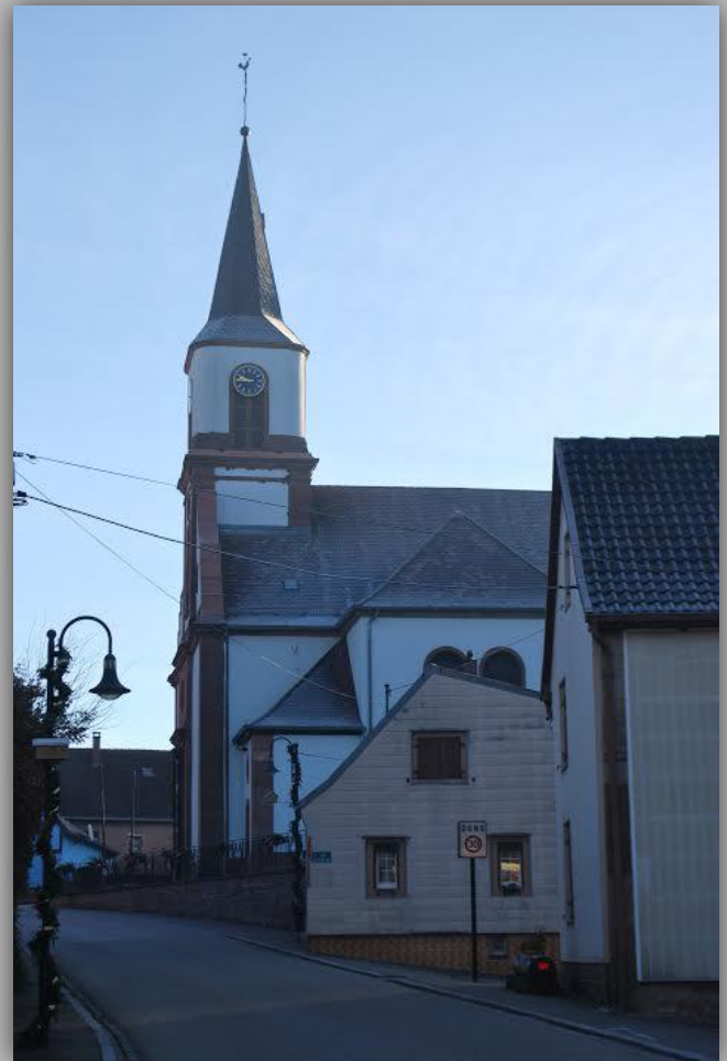
Travaux à l'église Saint Arbogast
